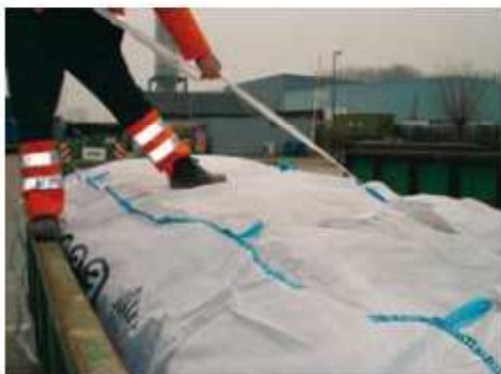
Stap 5: Hierna de lussen aan de binnenkant van een lange flap vastknopen aan de lange lussen. De overblijvende lange flap aan drie kanten met linten en lussen vastmaken.
