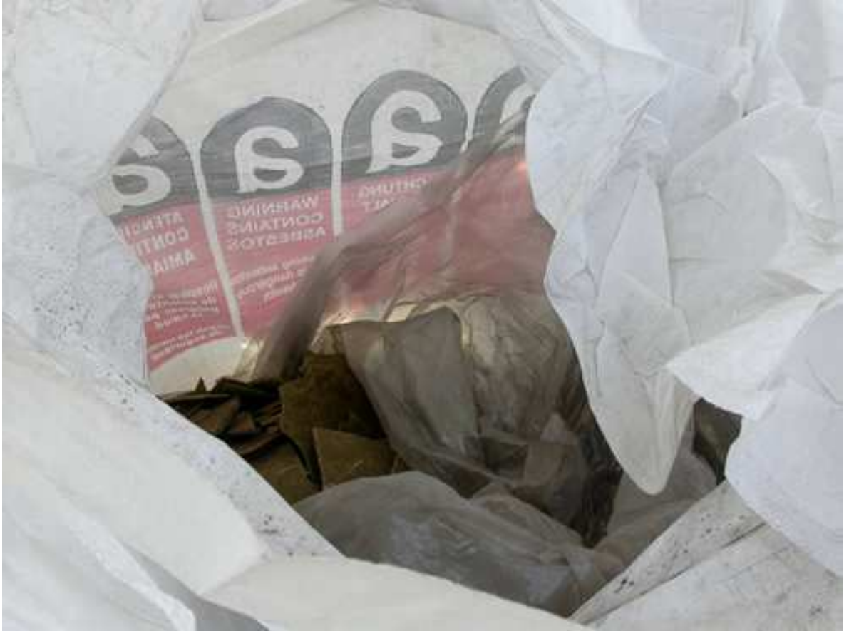
Figuur 3 Detailfoto van een big bag voor inzameling van HA op een Vlaams containerpark waarbij (in dit geval) duidelijk blijkt dat de binnenzak bij het vullen met materiaal loslaat
